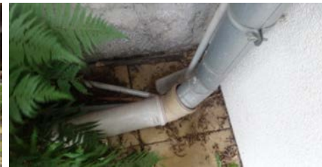
ukončení dešťového svodu na uliční straně RD
