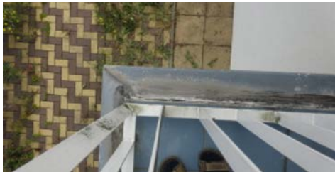
Tmelení oplechování balkonu
