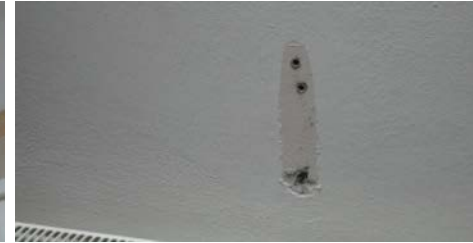
otvory ve zdivu po fixaci nábytku
