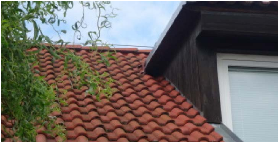
nepřiléhající pásek na hraně pultového vikýře a sedlové střechy
