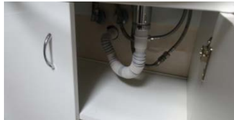
napojení umyvadla na kanalizaci flexi potrubím
