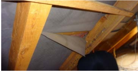
svěšená pojistná hydroizolace v podstřeší
