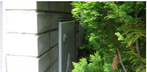
vegetace u přípojovacího a měrného sloupku
