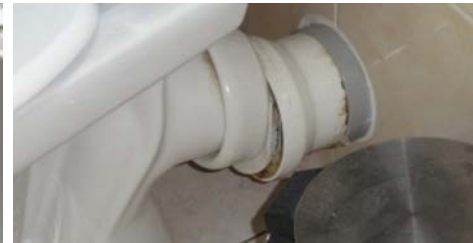
napojení WC mísy na kanalizaci
