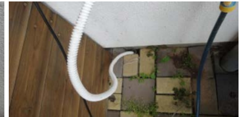
vedení kabelu z terénu
